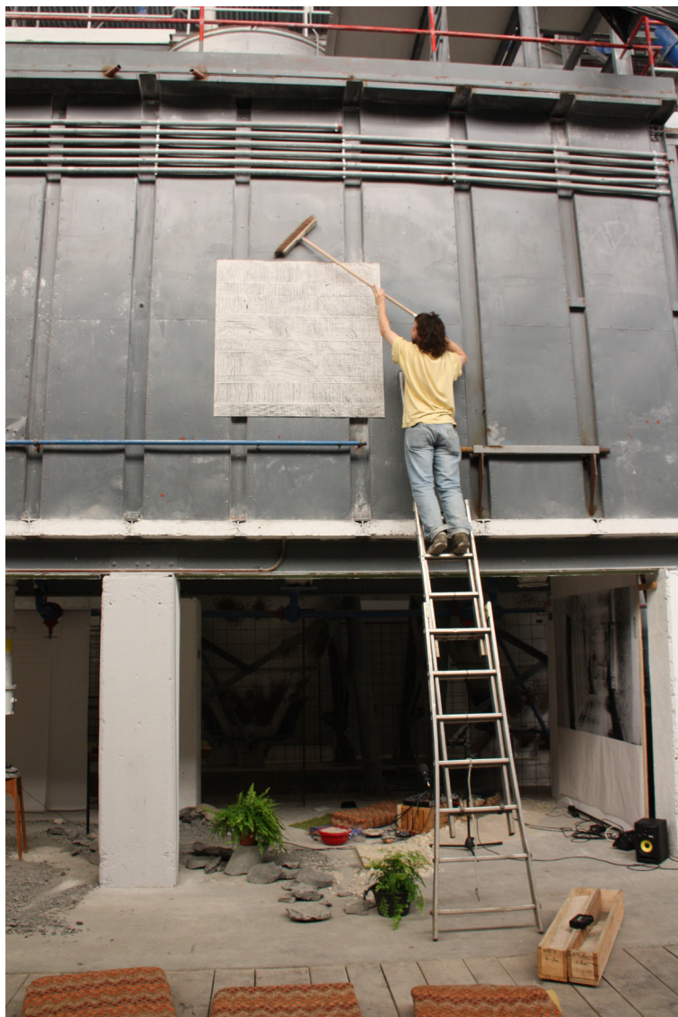
Installation de Léo Rebetez
